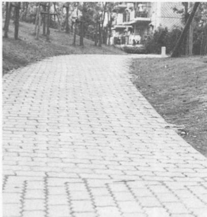
写真は遊歩道に使用するインターロッキングブロックの施工例
